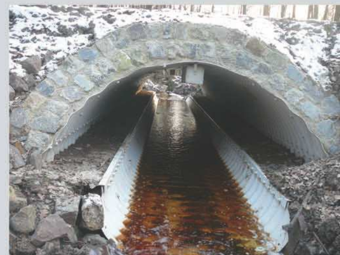
Neubau eines Wellstahldurchlasses mit Dimensionierung für naturnahe Durchlässigkeit, Gemeindefreier Bezirk Lohheide
